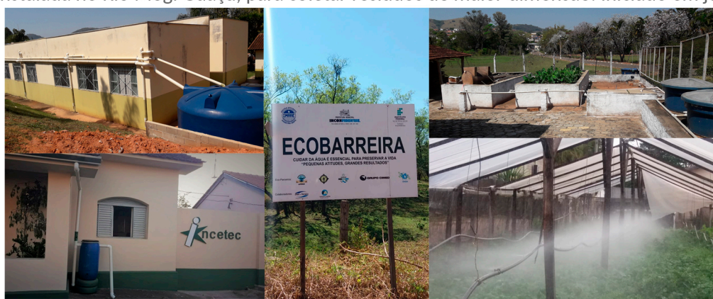
Sistemas eficientes de água e reaproveitamento
