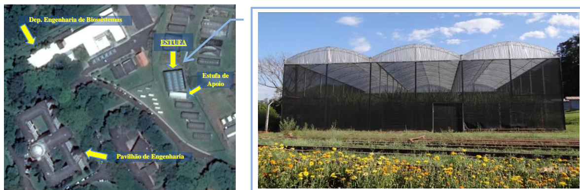
Figura 4 - Localização e imagem frontal da estufa instalada no Departamento de Engenharia de Biosistemas da ESALQ
