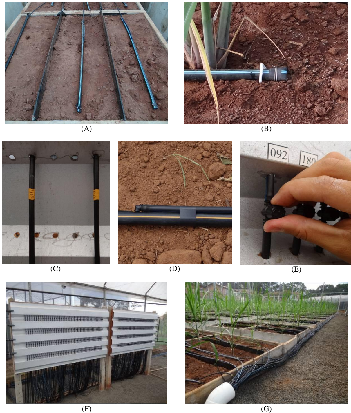
Figura 11 - Detalhes da montagem do sistema de irrigação. Linha de gotejo posicionada centralmente nas parcelas (A); Fixação da linha de gotejo com haste de PVC e lacramento das extremidades com fita veda-rosca e arame de aço inox (B); Anilha de identificação do microtubo (C); Microjoelho para ligação do microtubo à linha de gotejadores (D); Microrregistro instalado no painel de controle (E); Vista geral do painel de controle com 396 microrregistros (F); Vista geral da saída dos microtubos na estufa experimental para conexão com a linha de gotejo das parcelas (G)
