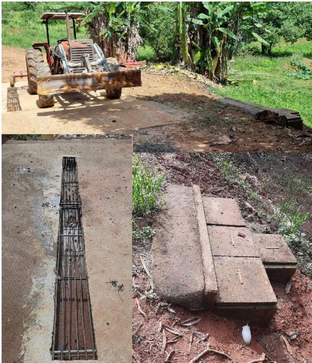
Figura 13. Sistema da Caixa Separadora de Água e Óleo (SAO) instalada no setor de Mecanização Agrícola.
