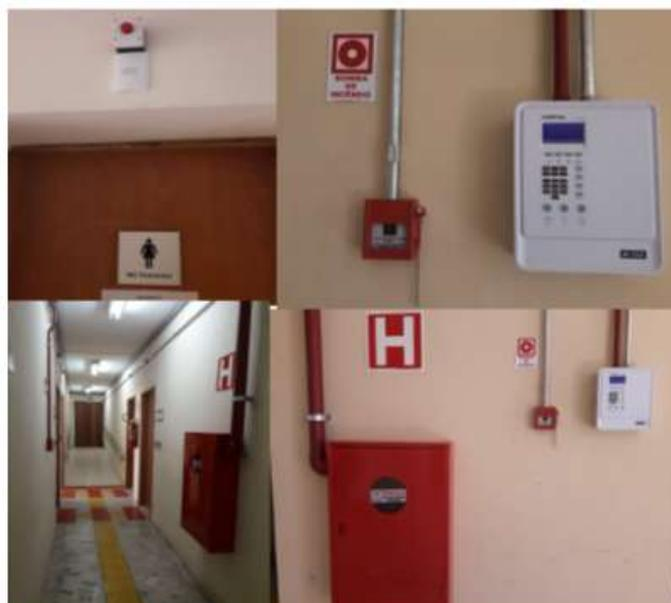
Figura 17. Elementos de *Green and Smart Buildings* do Campus Inconfidentes: Sensor de presença e sistemas de incêndio
