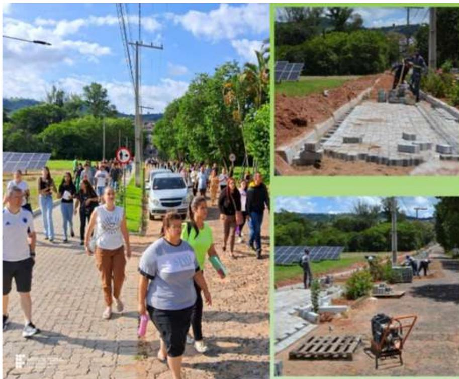
Figura 22. Passarela para pedestres pronta à esquerda x em construção à direita.
