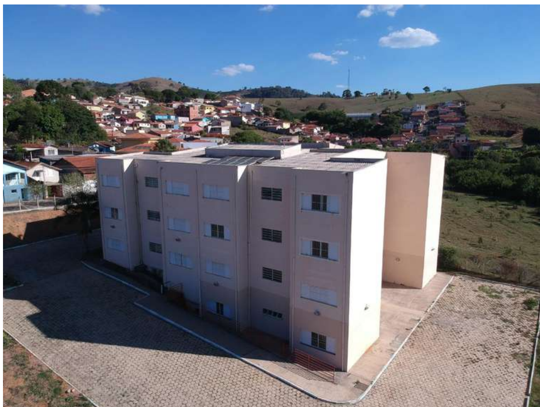
Figura 20 – Sistema de Aquecimento de Água no Alojamento Estudantil Visconde de Mauá
