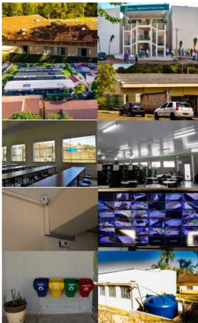
Figura 21 Elementos de Green and Smart Buildings do campus Inconfidentes: A) Sistema de exaustão; B) Iluminação e ventilação natural em todo o Edifício Estudantil; C e D) Painéis fotovoltaicos; E e F) Iluminação natural; G e H) Sistemas de vigilância por câmeras; I) Lixeiras seletivas de reaproveitamento; J) Captação de água pluvial.
