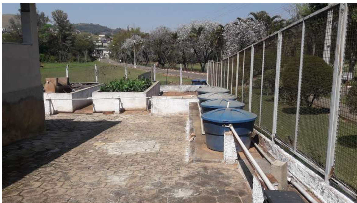
Figura 31. Estrutura da Wetland, com o tanque de filtragem ao fundo, com as plantas próprias para o processo.
