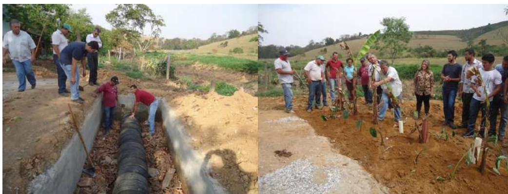
Figura 29. Instalação Fossa de evapotranspiração no setor de Bovinocultura de Leite
