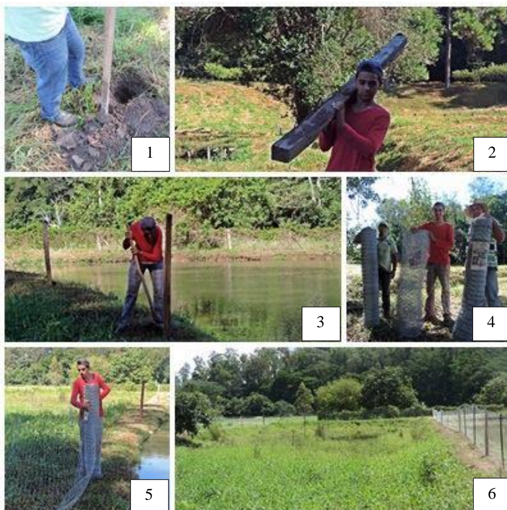
Figuras 1,2,3,4,5,6, – Montagem do experimento - isolamento do tanque.
