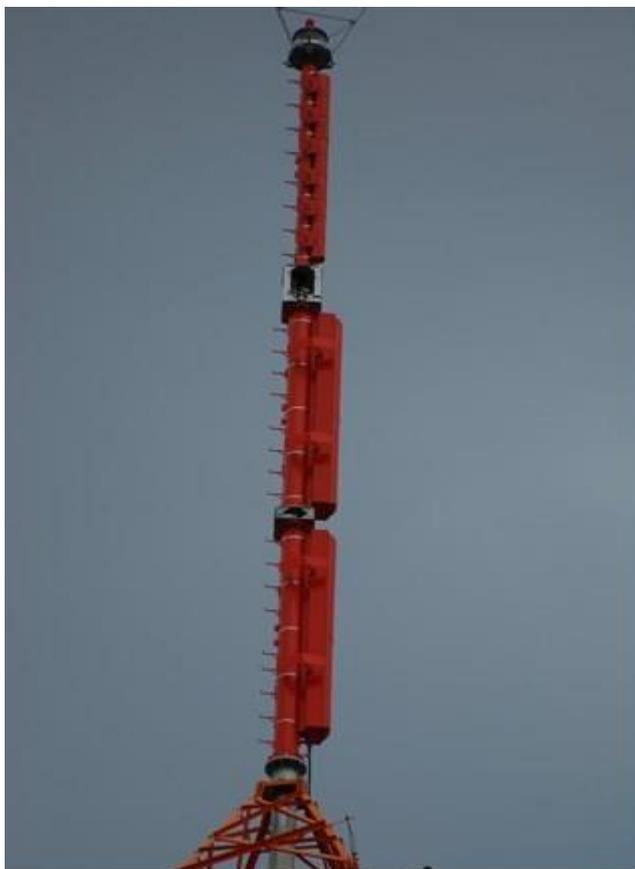
**Figura 6 - antena de transmissão do sinal digital modelo TTSLD2**
