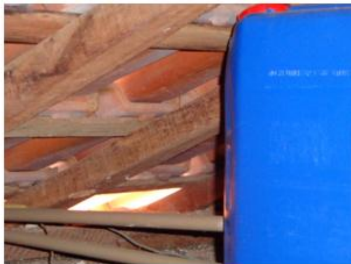
Figura 15: Reservatório de água instalado. Fonte: Elaboração própria
