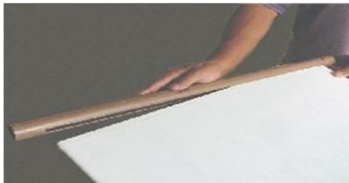
Figura 4: Encaixe do tubo na placa de PVC Modular.
