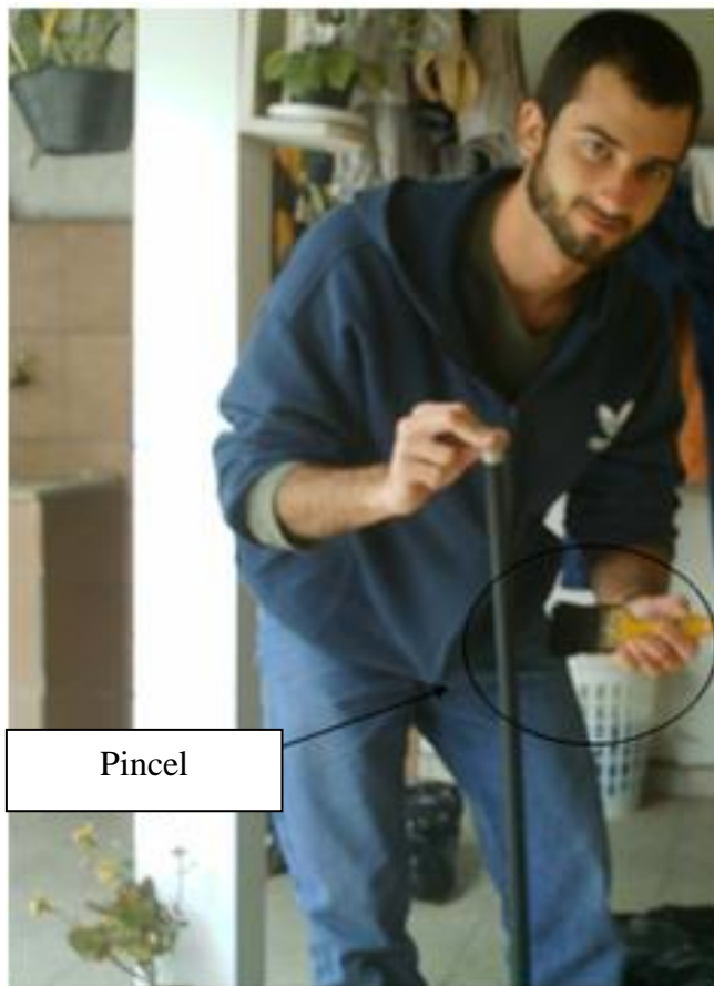
Figura 8: Pintando os Tubos de PVC. Fonte: Elaboração própria
