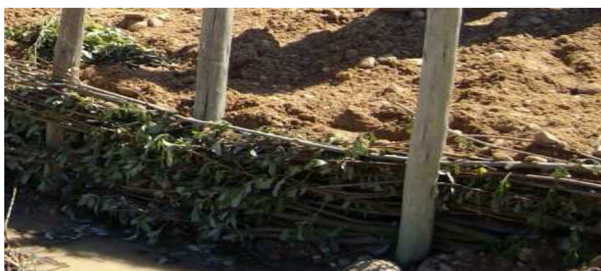
FIGURA 15: Técnica de entrançado vivo (Ferrari, 2000).
