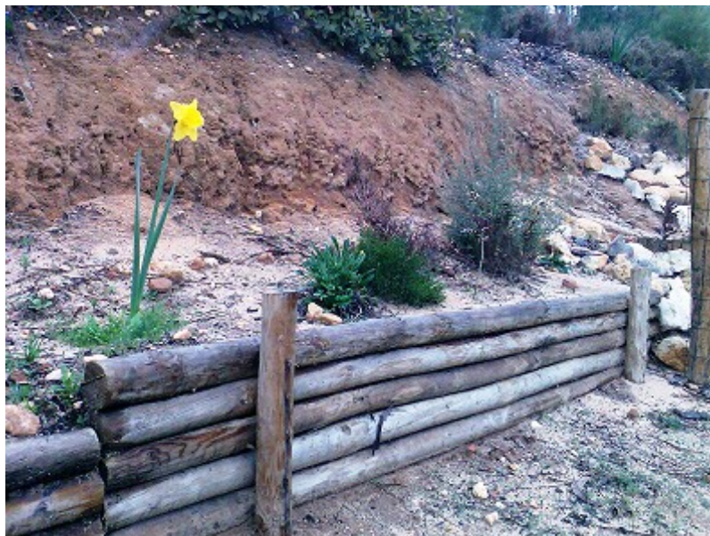
FIGURA 14: Técnica de paliçada viva (Matos, 2008).
