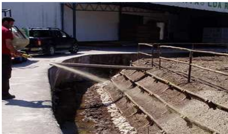
FIGURA 9: Aplicação da hidrosemeadura (Deflor, 2006).
