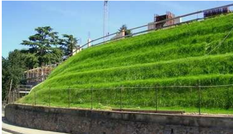
FIGURA 10: Hidrosemeadura após crescimento das espécies vegetais (Deflor, 2006).
