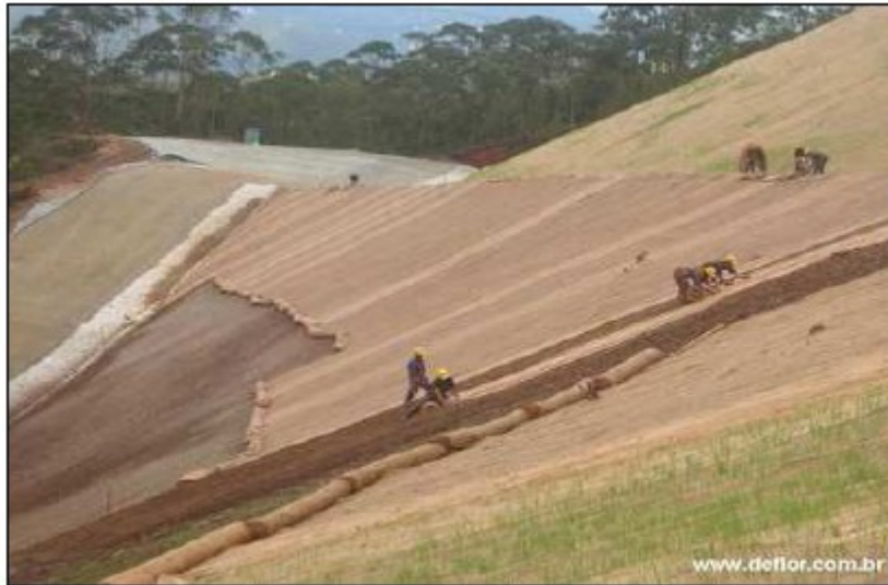
FIGURA 12: Aplicação da biomanta em um talude (Deflor, 2006).
