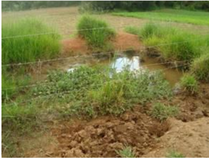
Figura 13: Bacias de contenção assoreadas. . (Foto: Arquivo pessoal).
