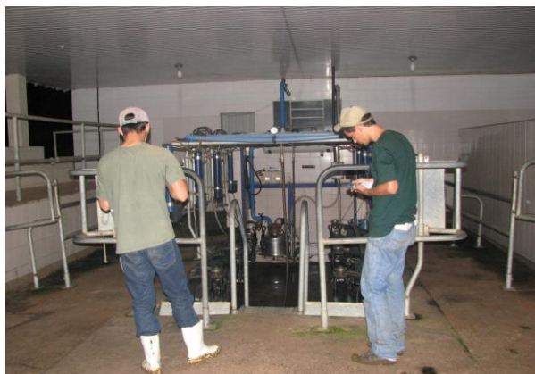
Figura 4. Medição da temperatura e umidade, ambiente sala de ordenha, com o aparelho Thermo Hygro.
