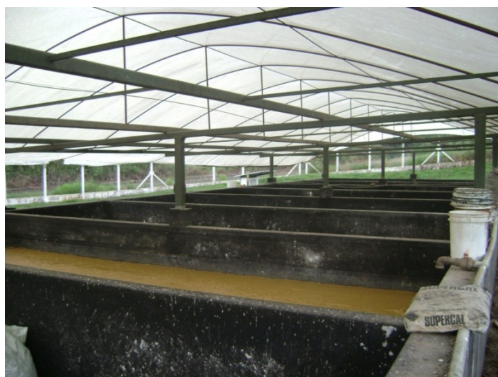
Tanque de aeração da estação de tratamento da indústria de bebidas.
