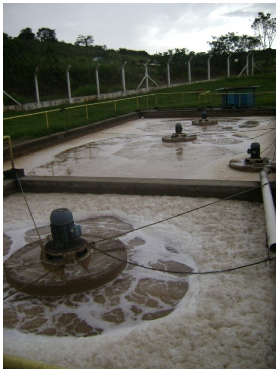
Tanque de aeração da estação de tratamento da indústria de bebidas.
