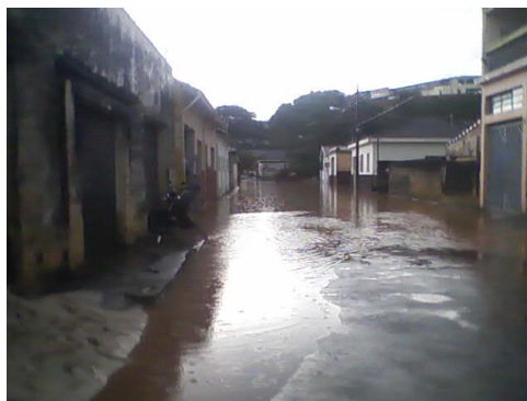
Figura 56 – Alagamento próximo aos chalés (Fonte: dados pessoais, Jan.2010).
