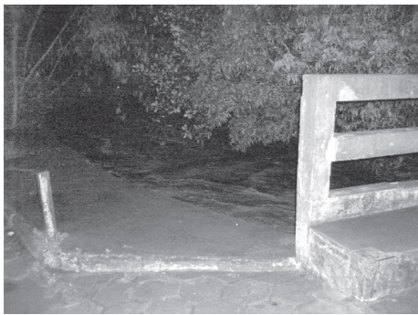
Figura 30 – Ponte na Rua Manoel Jesuíno de Carvalho (Fonte: Gazeta de Ouro Fino, Nov. 2006).
