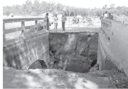
Figura 24 – Ponte que liga o Aeroporto com a MG 459 (Fonte: Gazeta de Ouro Fino, Nov. 2006).
