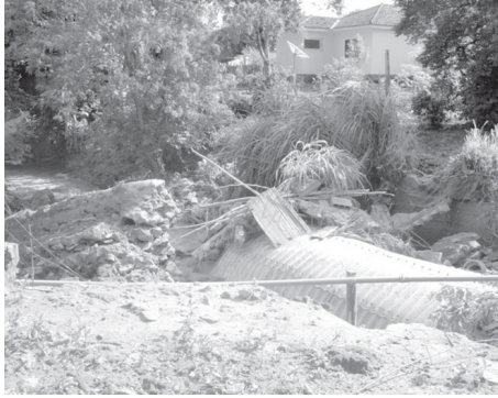
Figura 23 – Ponte no bairro Santa Rita caída (Fonte: Gazeta de Ouro Fino, Nov. 2006).
