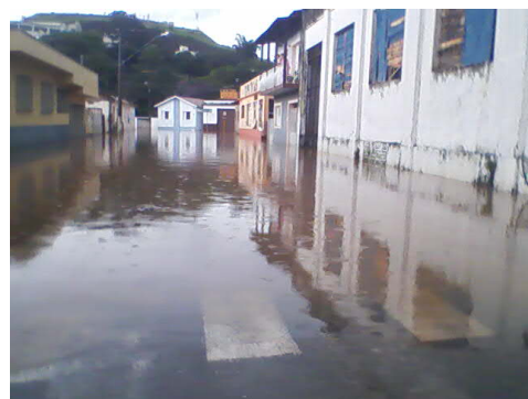
Figura 54 – Alagamento próximo à Praça da Baronesa (Fonte: dados pessoais, Jan.2010).
