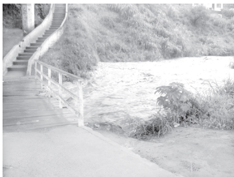
Figura 36 - Embaixo do viaduto da MG 290 (Fonte: Gazeta de Ouro Fino, Dez.2007)
