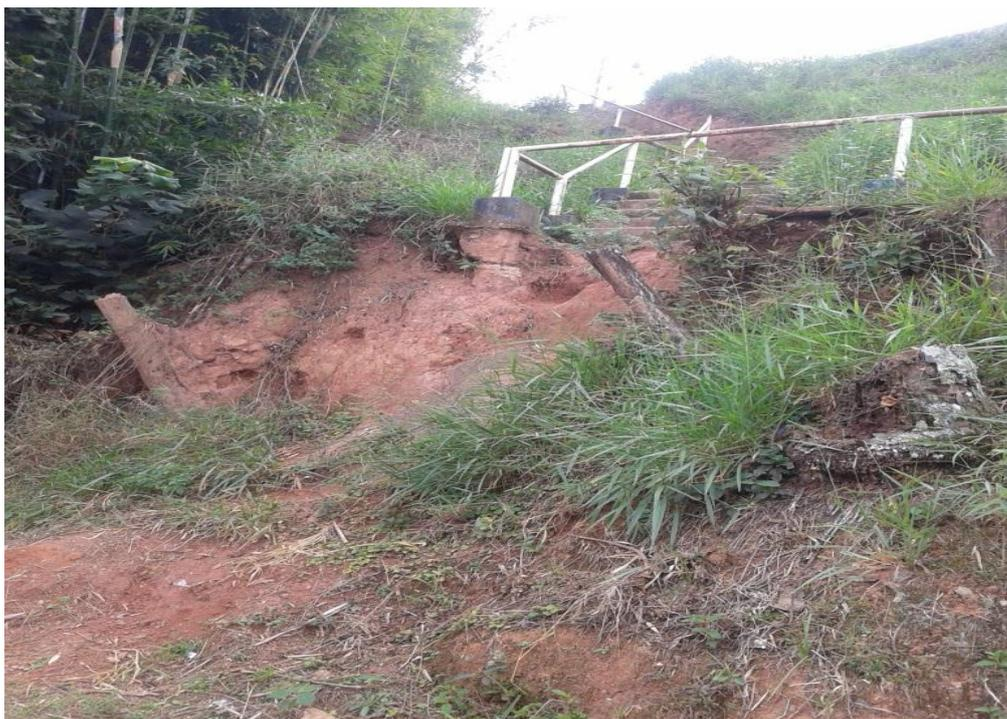
**Figura 32.** Processo erosivo na escada que facilita o acesso para os pedestres no bairro Jardim Ouro Verde (Fonte: Dados Pessoais).
