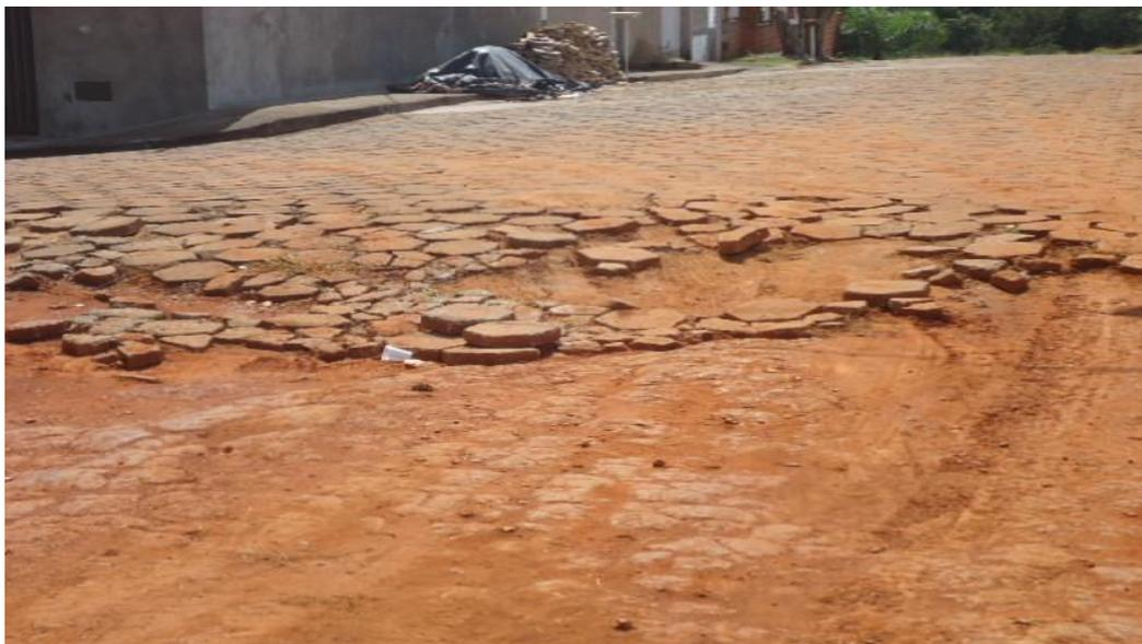
**Figura 22.** Vista da Rua do bairro Parque dos Palomos que está com calçamento prejudicado e instalação do processo erosivo (Fonte: Dados Pessoais).
