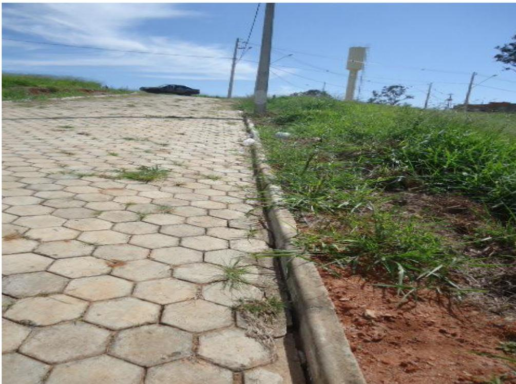
**Figura 24.** Exemplo de uma rua calçada com lote sem construção e somente com a guia feita sem calçada (Fonte: Dados Pessoais).
