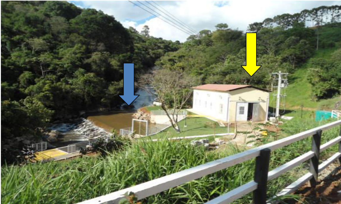
Figura 02. Detalhe CGH Cachoeirinha, indicando a barragem (seta azul) e a casa de máquinas (seta amarela). Fonte: (Parecer Único SIAM de N° 0788074/2013).
