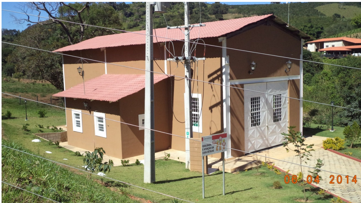
Figura 04. Detalhe da casa de força da CGH Limoeiro. Fonte: Patrícia A. Mapelli.
