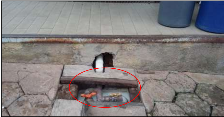
Figura 4: Canalização dos resíduos líquidos. IFSULDEMINAS – Câmpus Inconfidentes. Fonte: elaboração própria.
