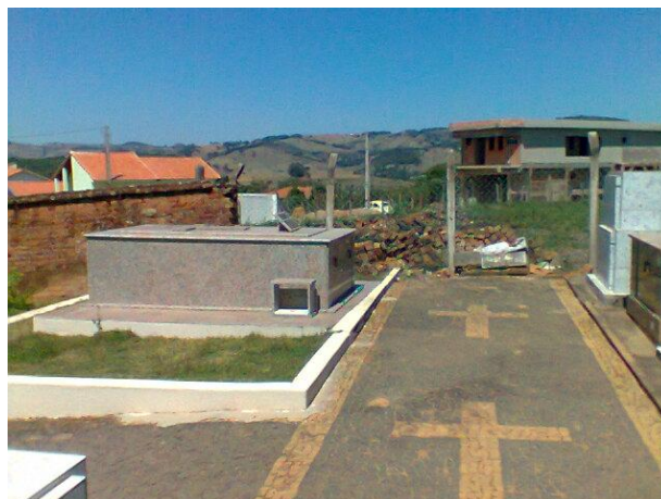
Figura 9- Muro demolido no interior do cemitério
