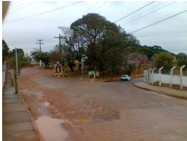
Figura 13- Rua de Acesso ao Cemitério após uma chuva
