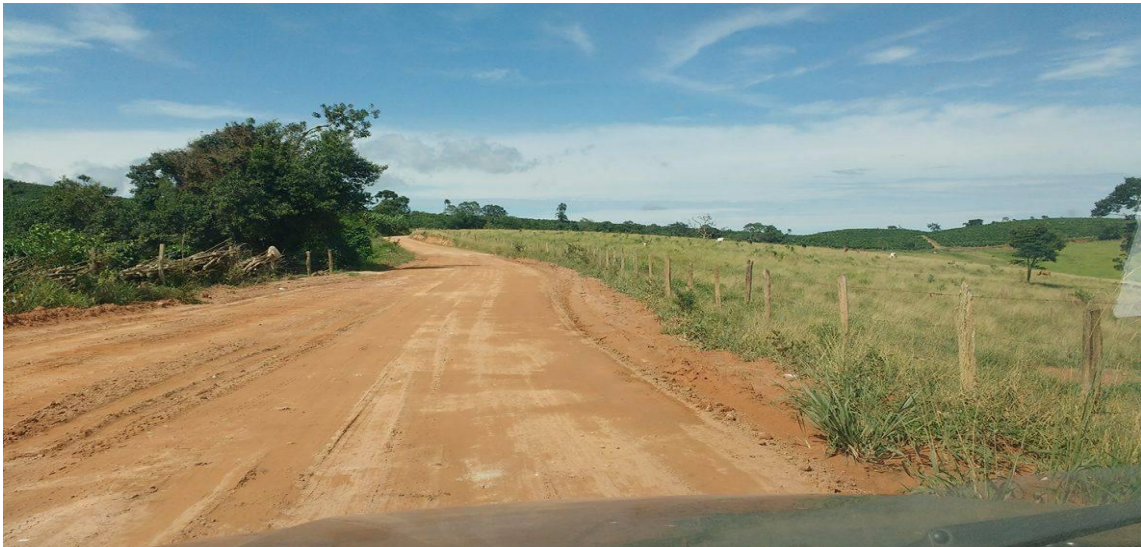
Figura 7: Estrada vicinal que dá acesso ao aterro/ Fonte: Próprio Autor.
