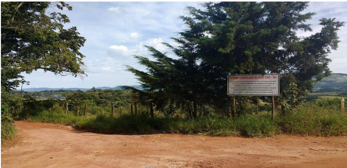
Figura 8: Estrada do aterro e ao fundo a mata nativa que serve como isolamento visual/ Fonte: Próprio Autor.
