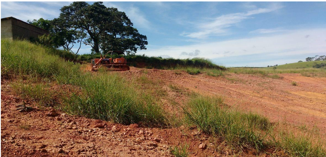
Figura 13- Trator esteira utilizado periodicamente no aterro. Fonte: Próprio Autor.
