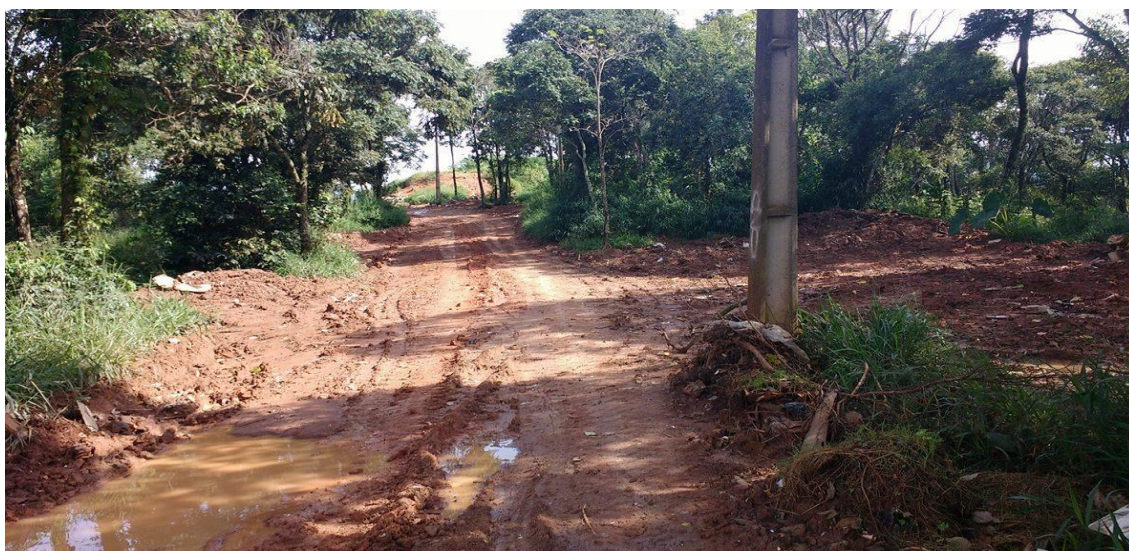
Figura 16: Acesso a frente de trabalho prejudicada pelo barro formado/ Fonte: Próprio Autor.
