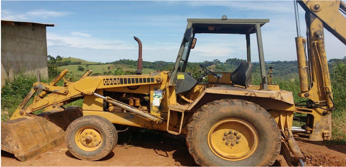
Figura 14: Retroescavadeira utilizada para auxiliar serviços no aterro/ Fonte: Próprio Autor.
