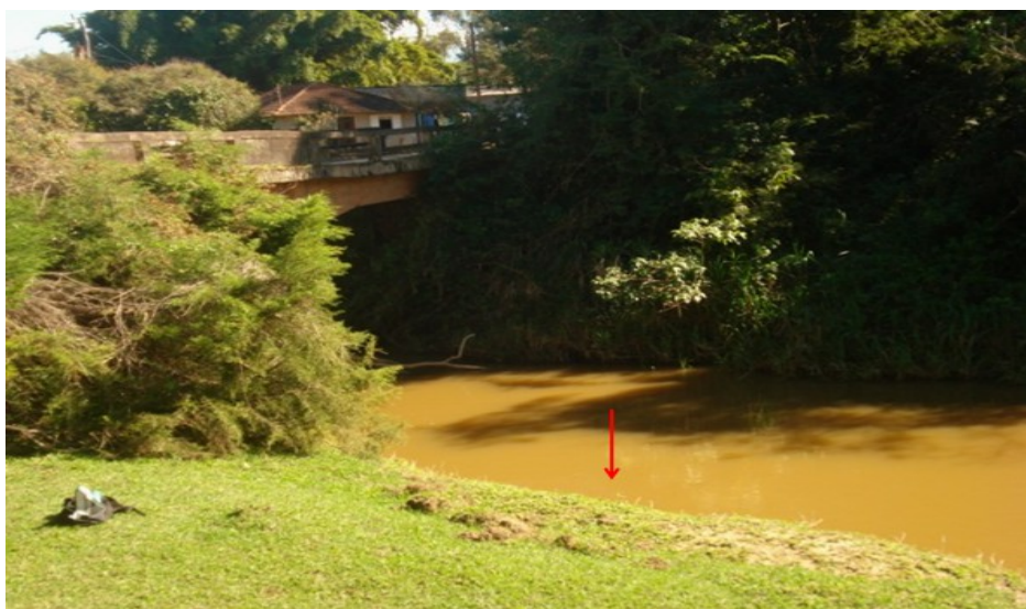
Figura 7. Montante da ponte da estrada de terra para Ouro Fino (Fonte: Elaboração própria).
