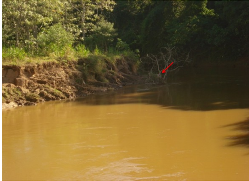
Figura 3. Montante da ponte da MG-295. (Fonte: Elaboração própria).
