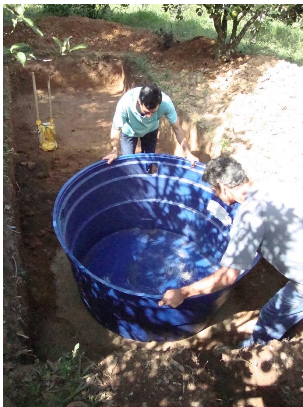
Figura 5: Implantação da fossa séptica. Fonte: Arquivo Pessoal, 2014.
