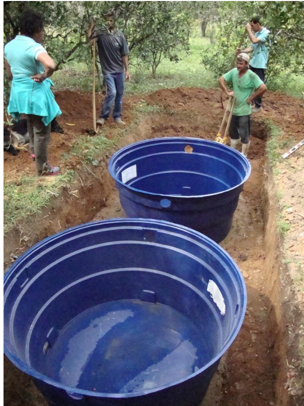
Figura 6: Implantação da fossa séptica. Fonte: Arquivo pessoal, 2014.
