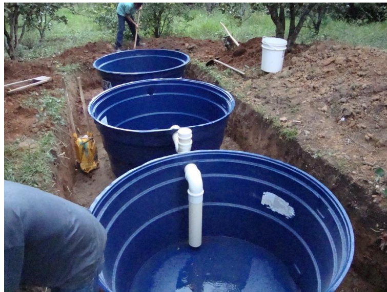
Figura 7: Implantação da fossa séptica. Fonte: Arquivo pessoal, 2014.
