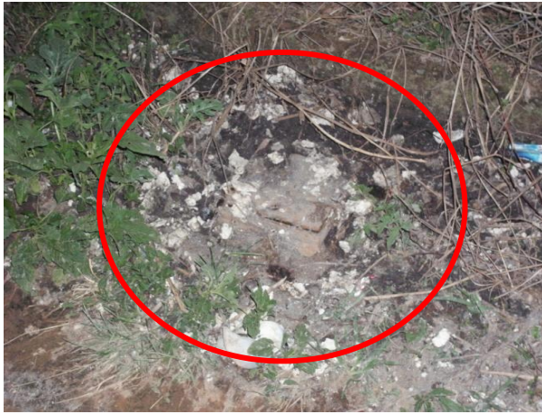
5 A- Caixa de esgoto em dias de chuva.
