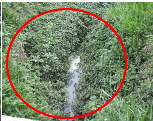
Figura 4 – Lançamento de esgoto no terreno baldio que acarreta diretamente para o Rio das Antas no município de Bueno Brandão/MG
