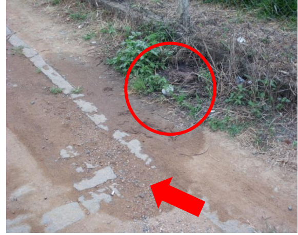
5 B- Vazamento de esgoto diretamente da caixa.
