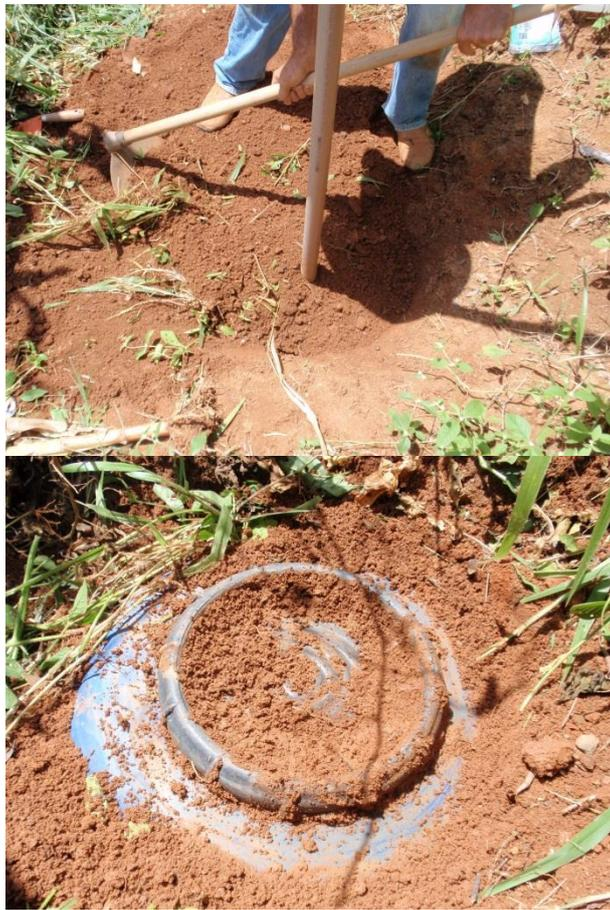
Figura 19: abertura do tanque séptico (Fonte: autoria própria).
