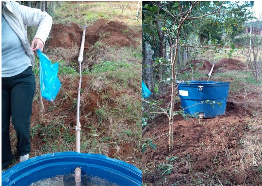
Figura 22: interligação entre o TS e leito cultivado (Fonte: autoria própria).
