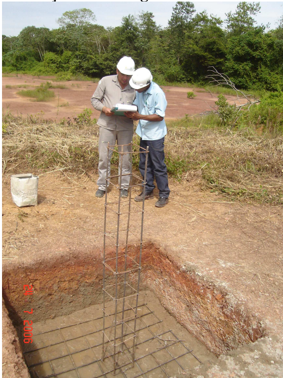
Colocação das ferragens das estacas e do pilar devidamente engastadas na ferragem da base
