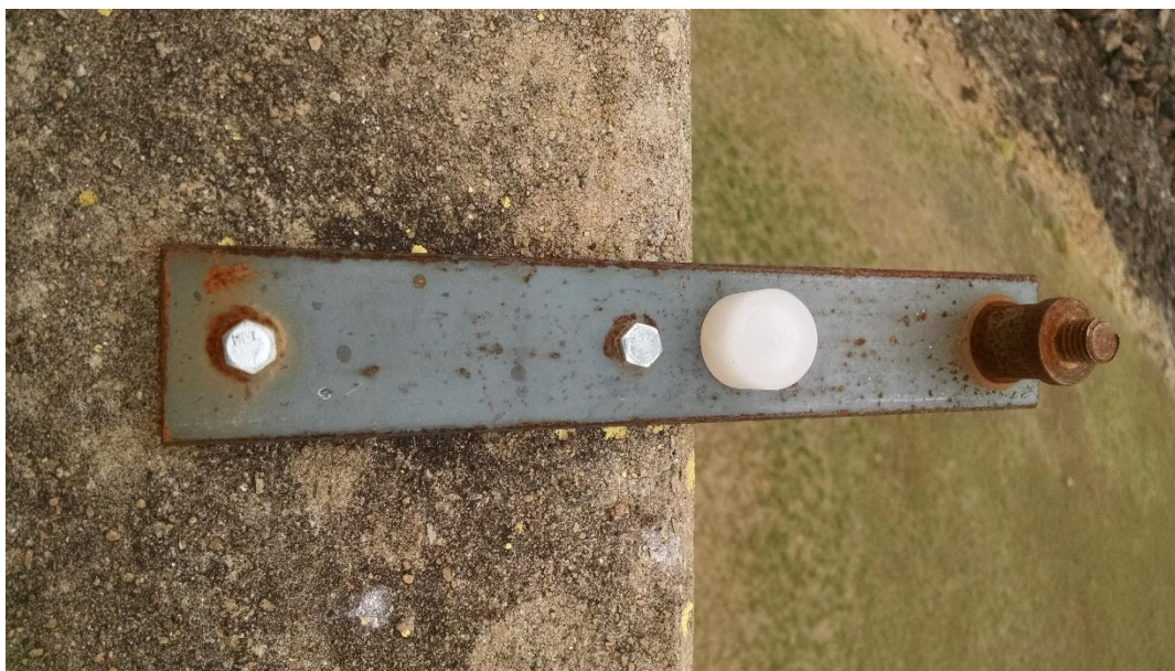
Figura 13 - Chapa de ferro inserida na crista da barragem
