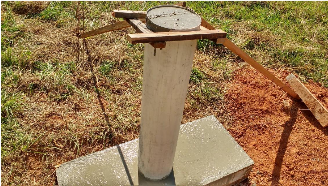
Figura 11 - Implantação dos pilares (Preenchimento com concreto)
