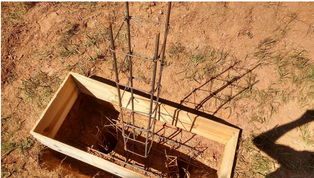
Figura 10 - Implantação dos pilares (Ferragem)
