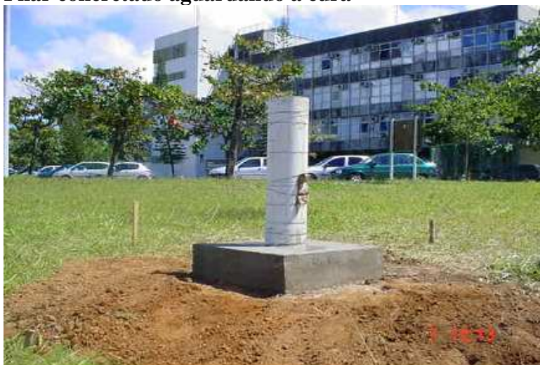
Pilar concretado aguardando a cura
