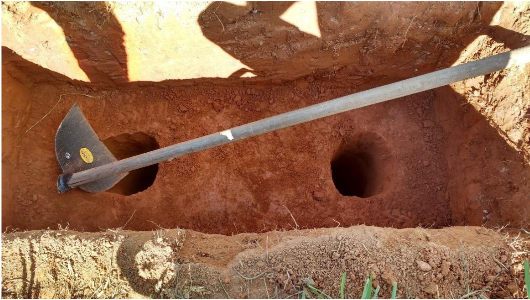
Figura 9 - Implantação dos pilares (Escavação)
