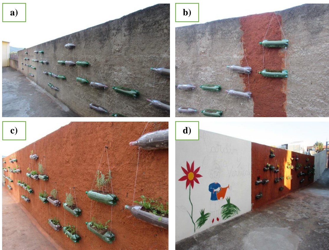
Figura.6. Construção do jardim vertical
