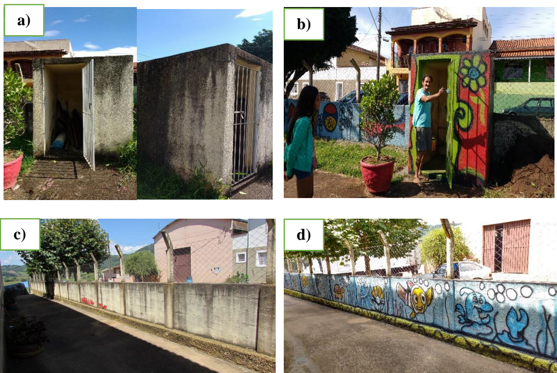
Figura.9. Melhorias na pintura do CEMAB
