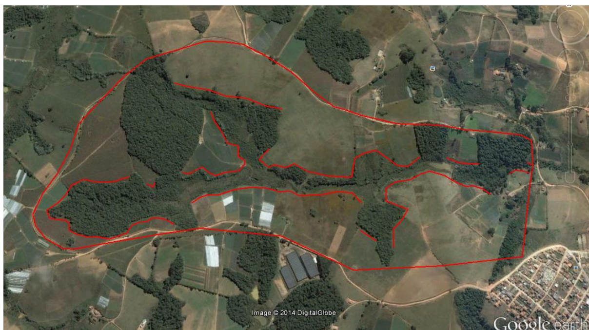
Figura 6 - Delimitação dos locais em que foram realizadas as bacias de contenção de águas das chuvas (Fonte: Google Earth Pro).
