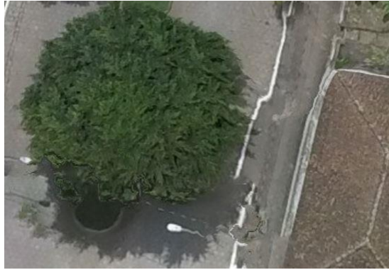
Figura 29: Distorção próximo à árvore.
