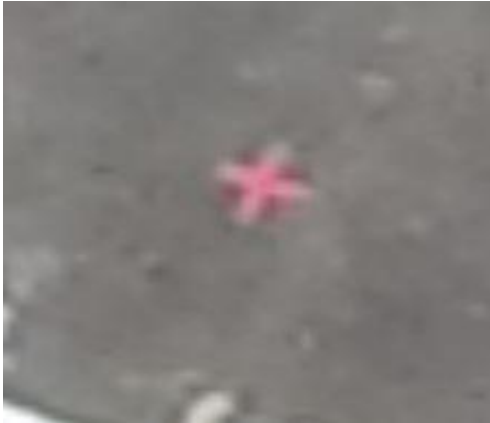
Figura 21: Alvo vermelho na foto no cimento.
