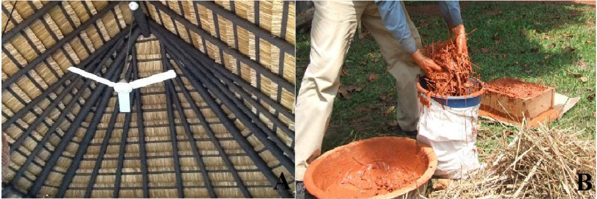
Figura 2. Cobertura de Sapê feita com o capim Vetiver (A) e Confeção de tijolos de argila e folhas de vetiver (B). (Fonte: Vetiver Soluções Ambientais, 2014 (A), Natural Building Blog (B)).
