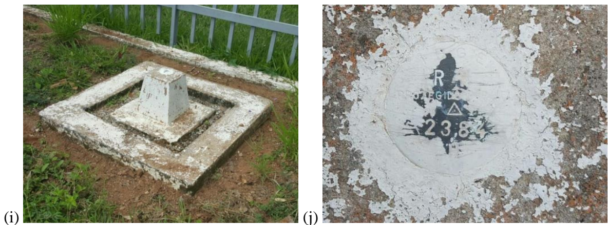
Figura 29 – (i) Tronco Piramidal, (j) Chapa de identificação RN 2384 H. Fonte: Próprio Autor.
