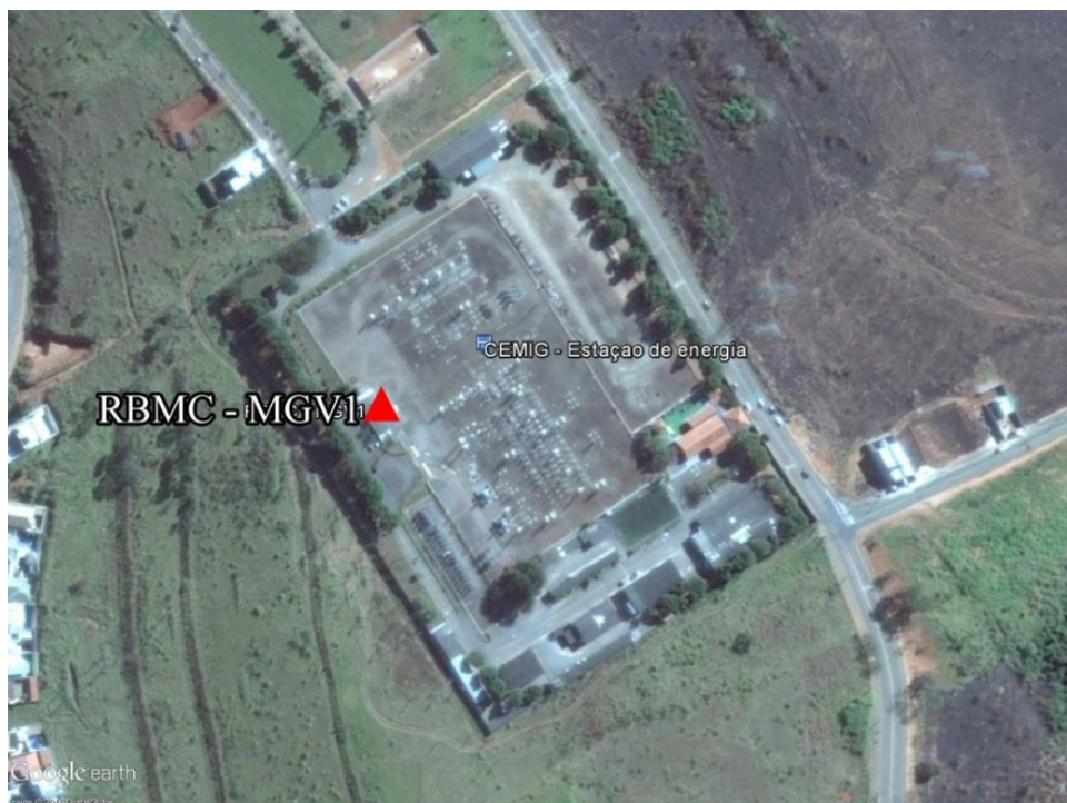
Figura 43 – RBMC MGVI dentro da estação de energia da CEMIG. Fonte: Google Earth Pro.
