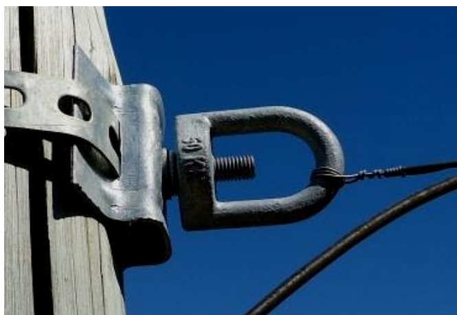
Figura 48 - Conjunto de Ancoragem.
