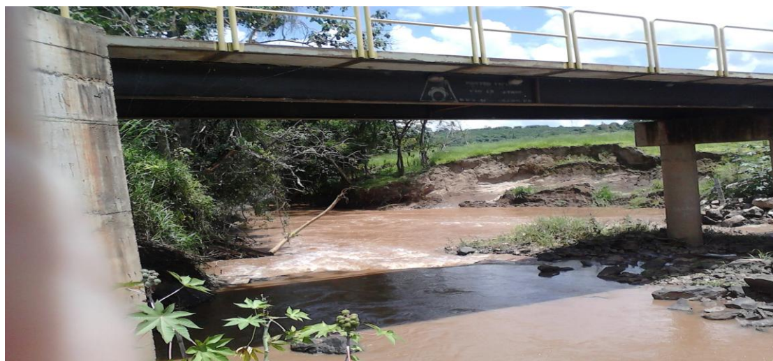
Figura 8 - Ponte no bairro Córrego da Onça em Inconfidentes.
