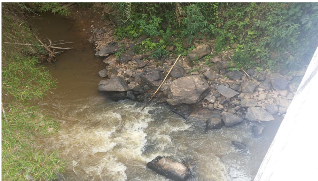
Figura 10 - Ponte localizada no IFSULDEMINAS-Câmpus Inconfidentes.
