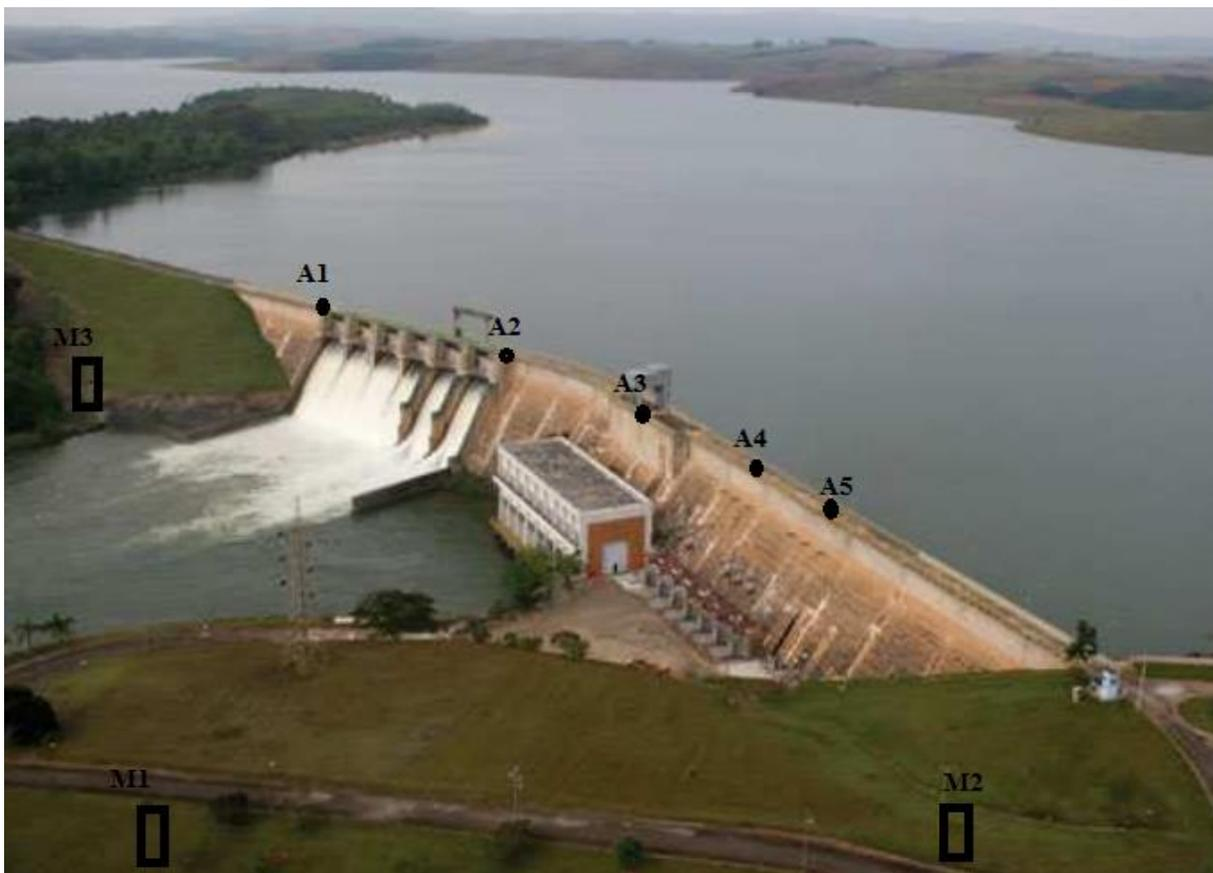
A estação total foi posicionada em cada marco, instalada e nivelada. Em seguida fez-se a visada a ré com um ângulo de  $0^\circ$  e em seguida fez-se a leitura direta e inversa na vante, o mesmo processo é realizado com angulosas direções iniciais de  $45^\circ$ ,  $90^\circ$  e  $135^\circ$ .
