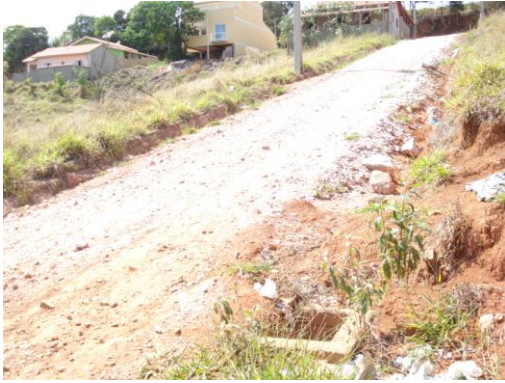
Figura 9- Ruas em processo erosivo Fonte: OLIVEIRA, C. A. de (2011).
