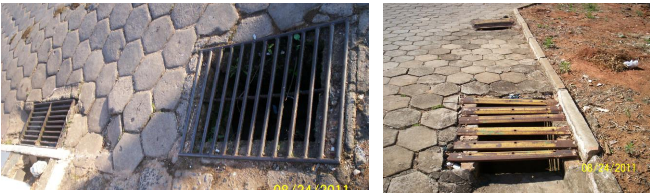
Figura 14- Bueiros com aproximadamente 2 metros de distância
