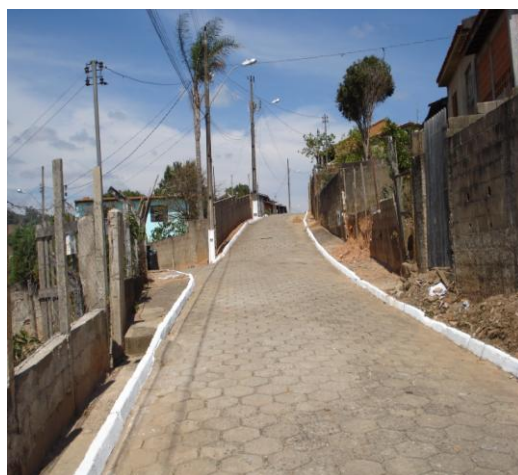
Figura 4 – Diferença da largura das ruas de bairros para a região central no município de Inconfidentes/MG. Fonte: OLIVEIRA, C. A de (2011).
