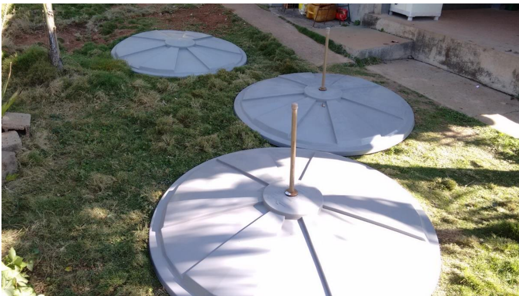
Figura 15: Tampas com flange, tubo e cap soldáveis de 25 mm instalados.
