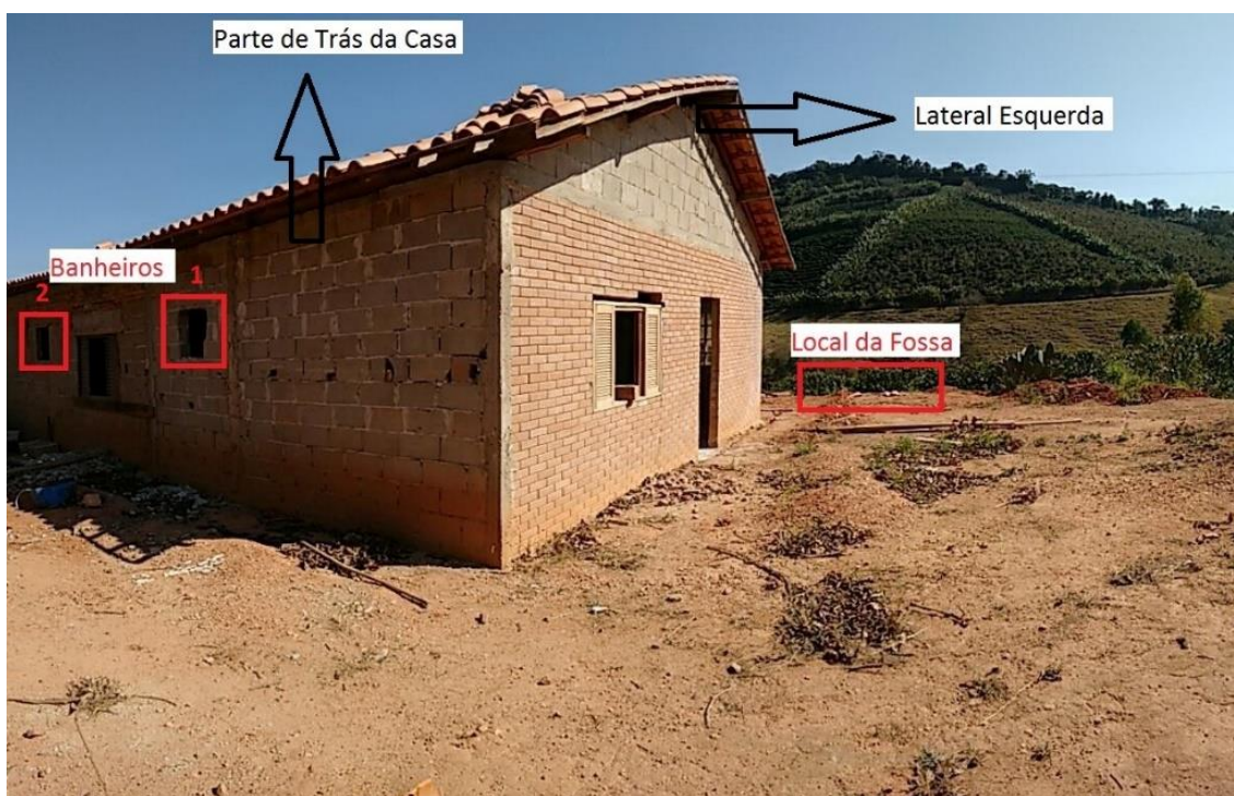
Figura 09: Localização do banheiro e onde seria a implantação do sistema biodigestor – Residência em fase de construção.
