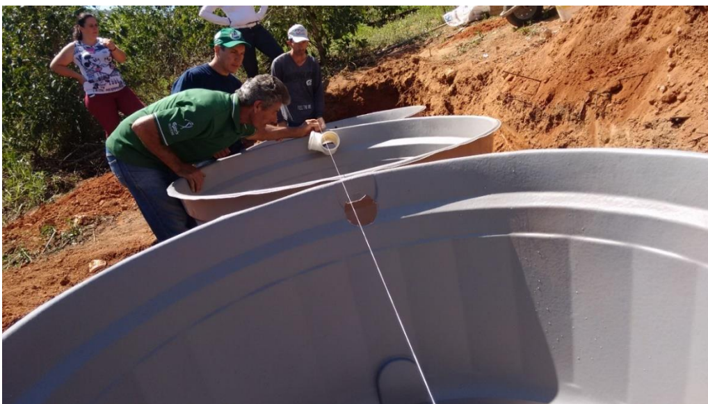
Figura 12: Nivelamento das caixas d'água de 1000 Litros.
