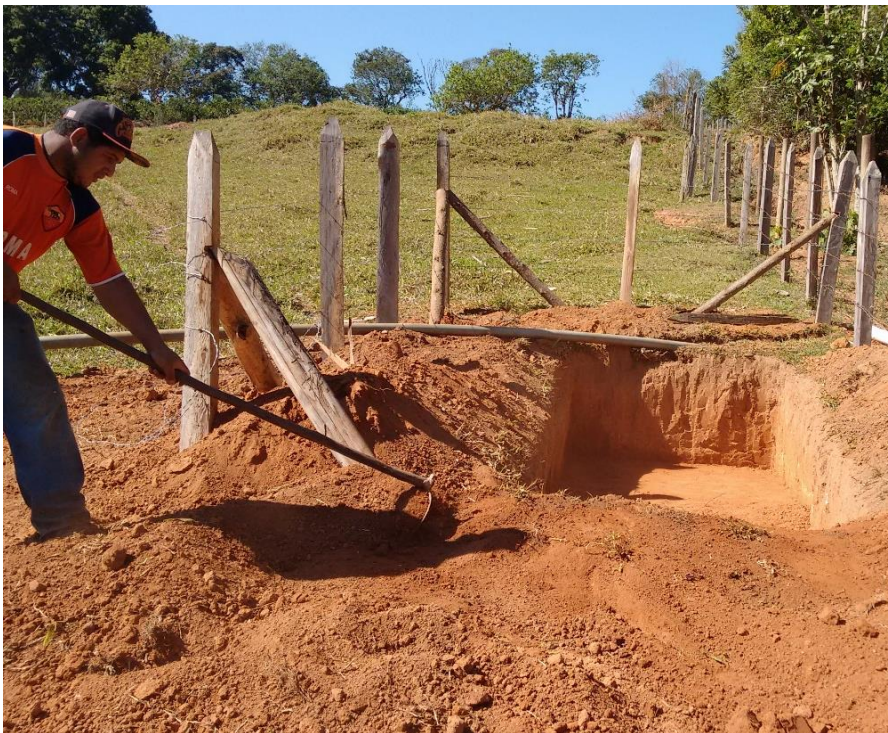
Figura 10: Preparação do local de implantação do sistema de fossas sépticas.
