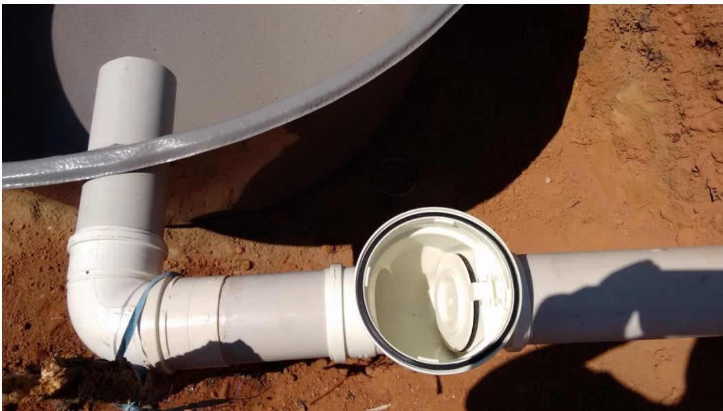
Figura 17: Válvula de retenção de PVC 100 mm e seu interior.
