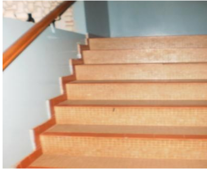
FIG.1 fonte: Pessoal. Escada que dá acesso ao segundo piso. janeiro/2013
