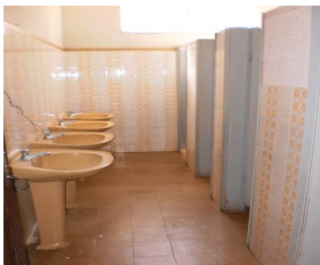
FIG.3.Fonte: pessoal. Banheiro 1º piso.janeiro/2013
