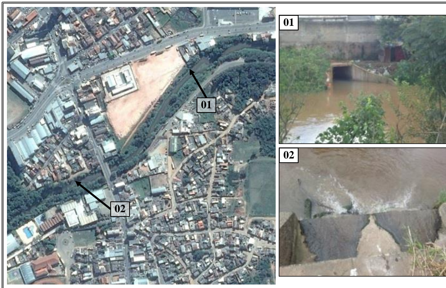
Figura 12. Rede de drenagem de água pluvial.
