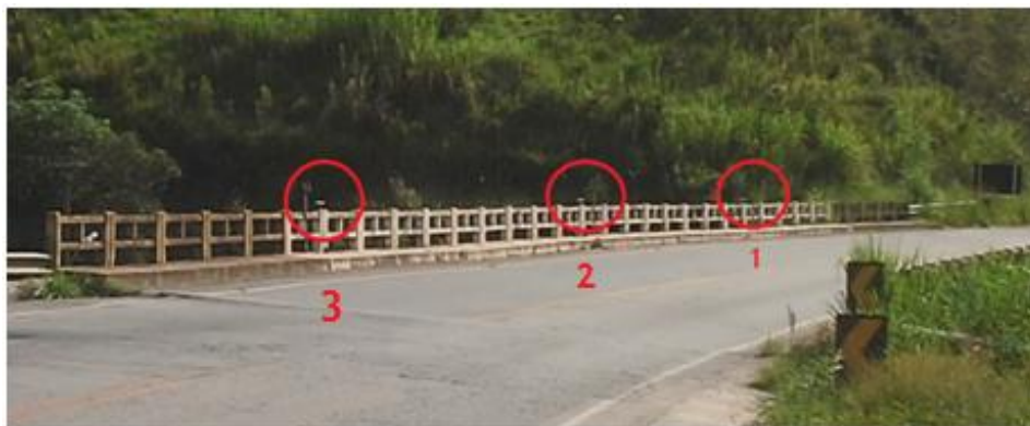
Figura 3 - Distribuição dos pontos fixos sobre a ponte.
