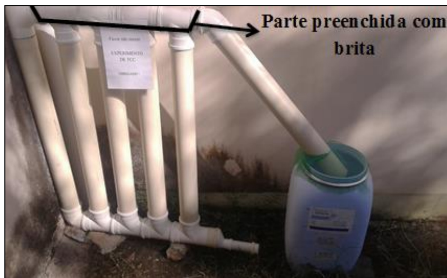
Figura 05. Identificação do local preenchido com brita.
