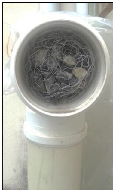
Figura 06. Preenchimento de brita envolvida por tela de galinheiro.
