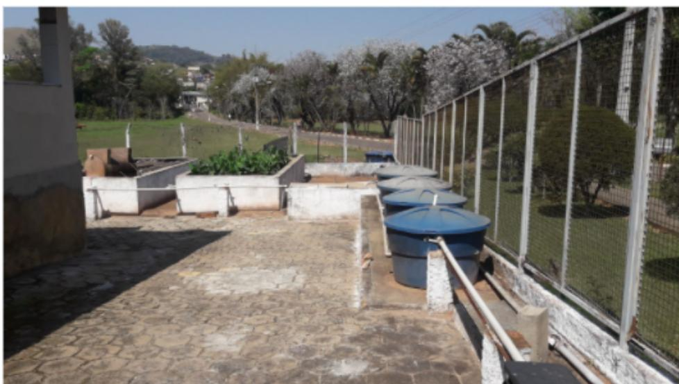
Figura 25. Estrutura da Wetland, com o tanque de filtragem ao fundo, com as plantas próprias para o processo.
