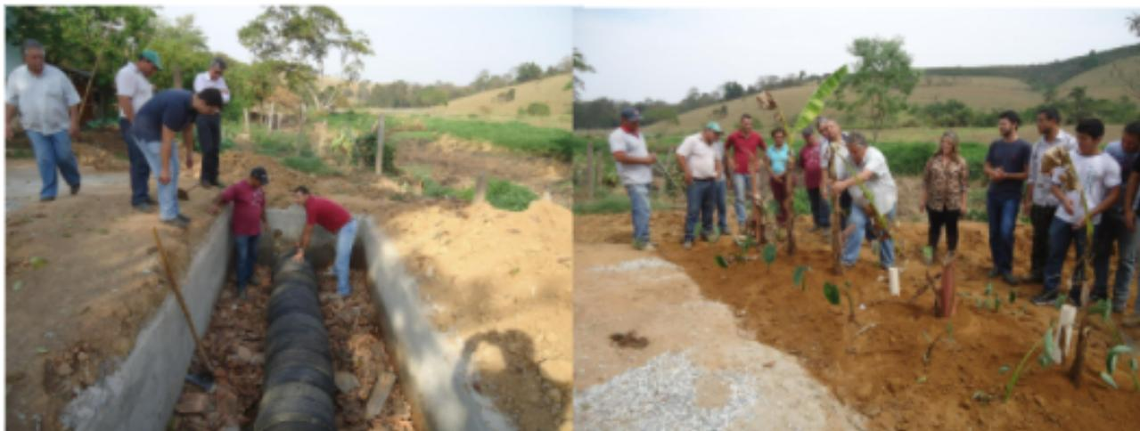
Figura 23. Instalação Fossa de evapotranspiração no setor de Bovinocultura de Leite
